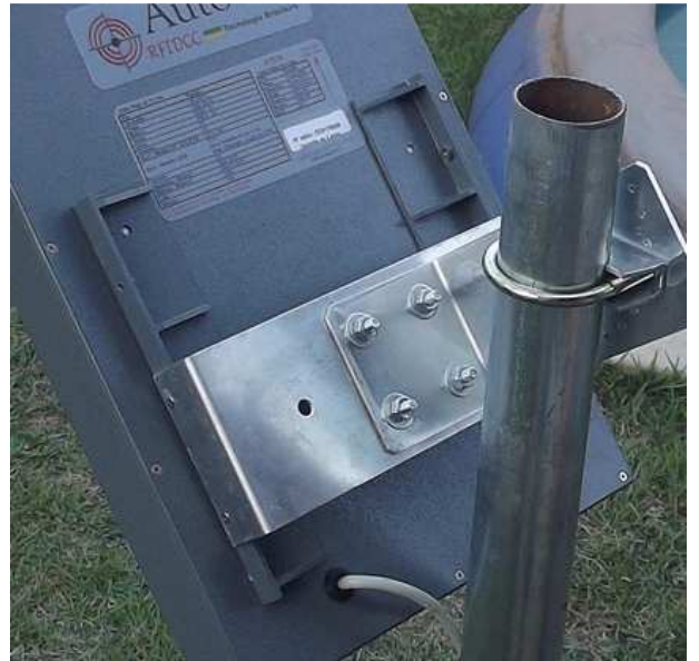
Fixação em poste vertical com leitor a 45° (recomendado para leitor acima de 2 m de altura) usando suporte em “U” e em “L”
