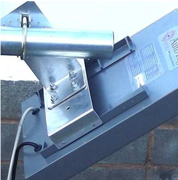
Fixação em poste horizontal com leitor a 45° (recomendado para leitor acima de 2 m de altura) usando suporte em “U” e em “L”
